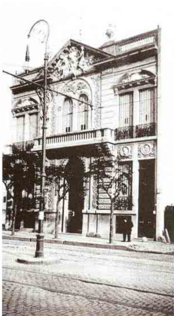
Casa Fondazione Margherita di Savoia (intorno al 1892)
